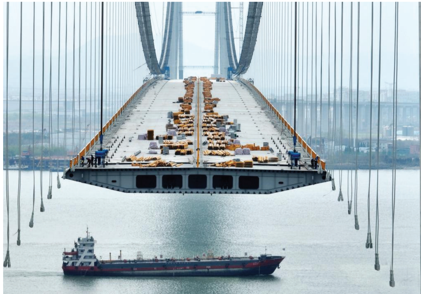
3月26日拍摄的龙潭长江大桥建设现场(无人机照片)。
