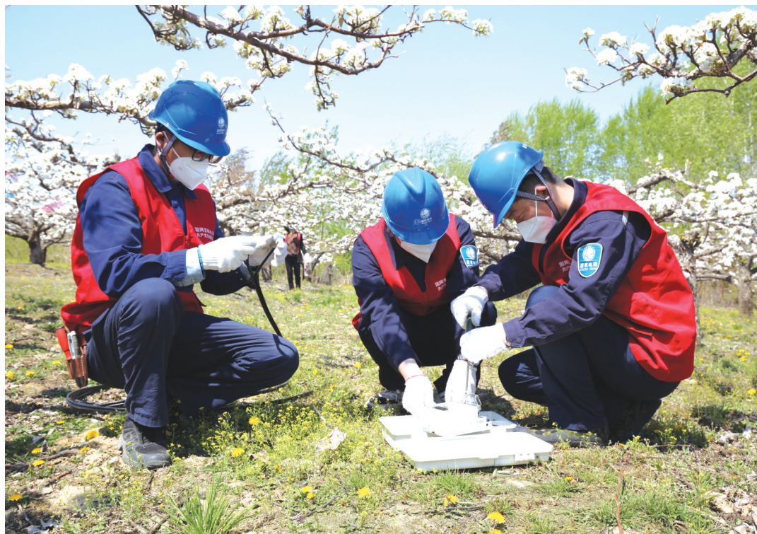
图为国网珲春市供电公司党员服务队队员为苹果梨园排灌设备安装计量装置。
